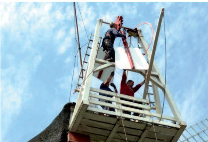
Mühlenhandwerker Günter Ropers (li.), wie er die Speichen aufwändig wieder einzeln eingepasst und befestigt.
