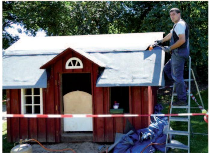
Die alte Pappe ist undicht. Frank Penning verschweißt das Dach neu bei 28°C kein Geschenk!
