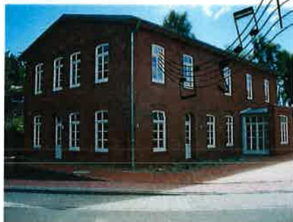
Musikschulgebäude in der Ziegeleistraße 16 in Langen
